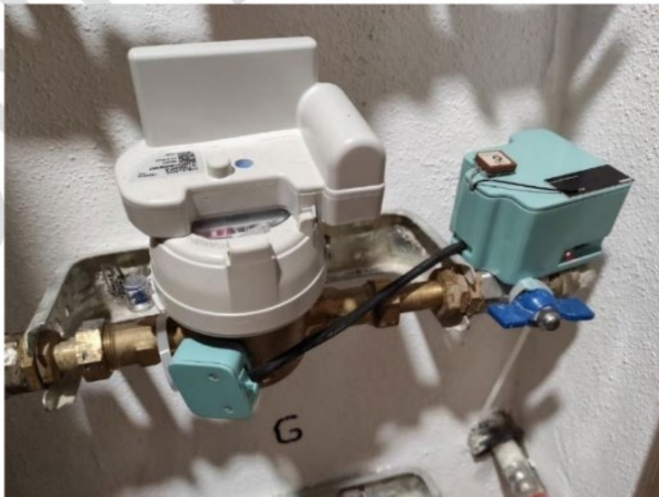
- Sistema de deteção de fugas (versão 2)
